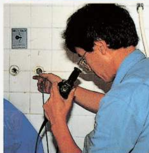
2回ライニングの塗膜が薄い場合には必要な作業を再度行います。
