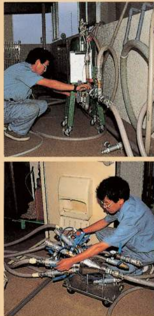
高速の空気流と研磨剤によるパイプ内部を2方向研磨でサビ等を除去。
