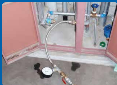
復旧後気密試験
